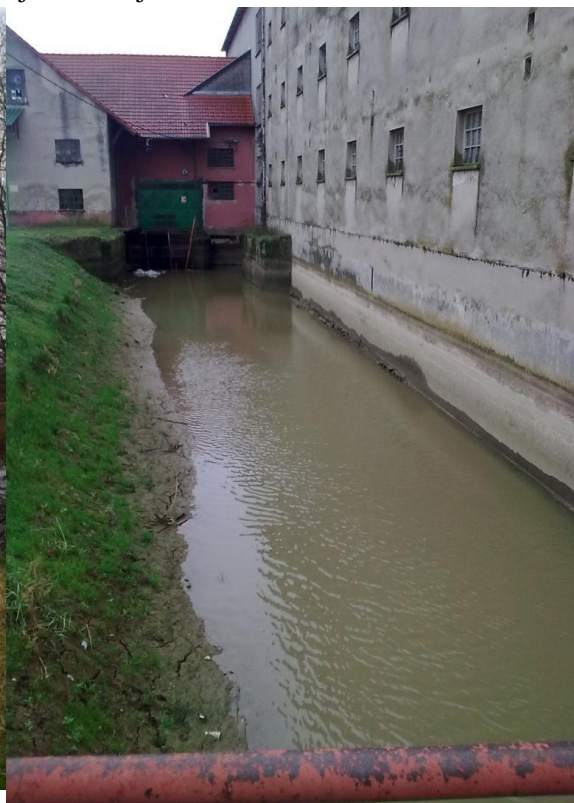
Slika 6: Gornji derivacijski kanal neposredno pred ulaz u malu hidroelektranu
