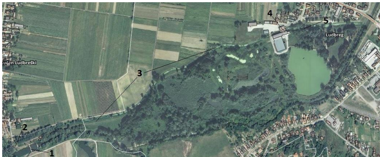
Slika 2: Orto – foto snimka sa označenim najvažnijim dijelovima hidroelektrane
